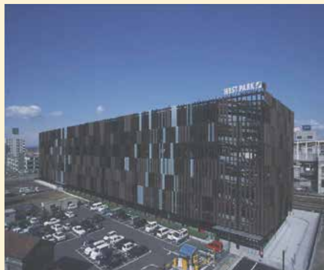
高崎駅西口北第一地区（施工後）
