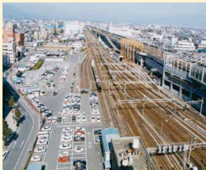
高崎駅西口北第一地区（施工前）
