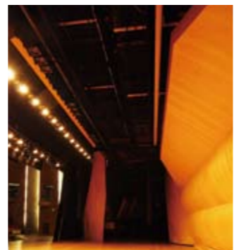
そこで部分から舞台を見た写真。舞台天井は低い。この部分は外壁自体に高さがないという構造上の問題がある
