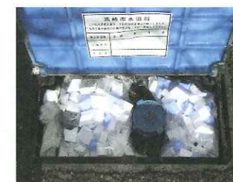
発泡スチロールを入れたビニール袋をメーターボックス内に詰めた状態
