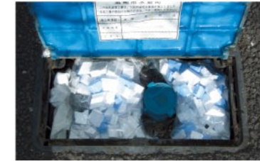
発泡スチロールを入れたビニール袋をメーターボックス内に詰めた状態
