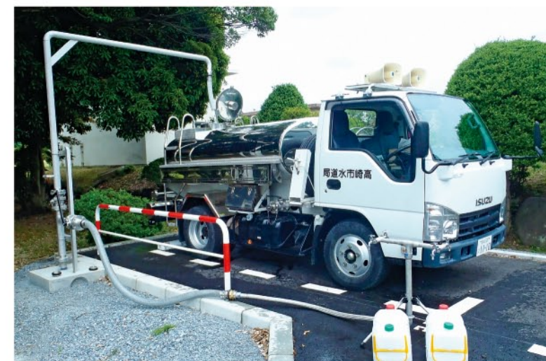
若田浄水場に設置された給水塔
