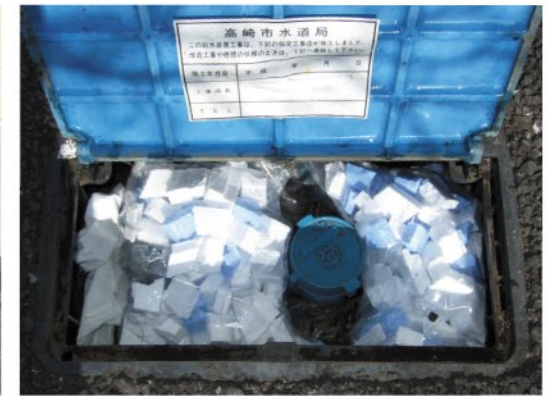
発泡スチロールを入れたビニール袋をメーターボックス内に詰めた状態
