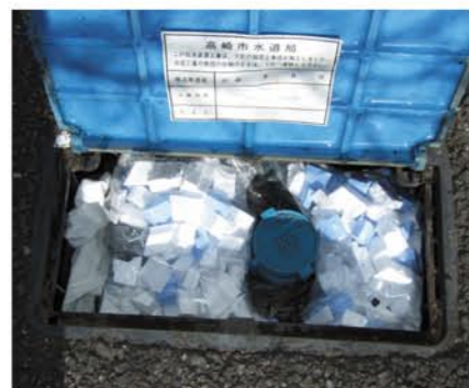
発泡スチロールを入れたビニール袋をメーターボックス内に詰めたとした状態
