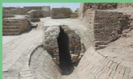
世界で最も古い下水道と言われる古代インド・モヘンジョ・ダロのレンガ造りの下水道。▲
