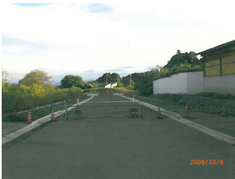
20年度施工箇所から県道箕郷板鼻バイパス線方向
