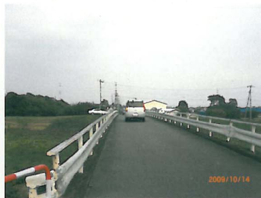
天神橋 西側から撮影
