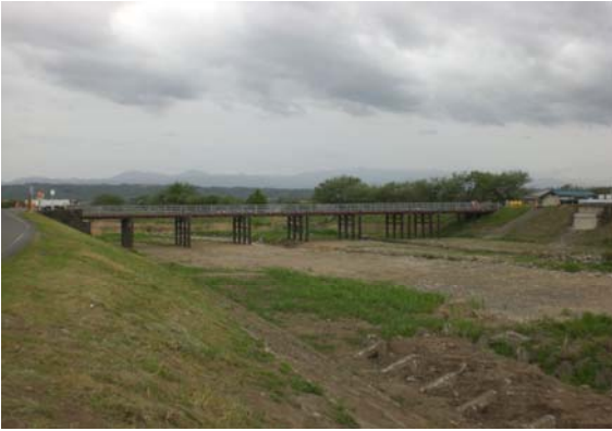
●仮設橋全景 (南方向より) (完成)
