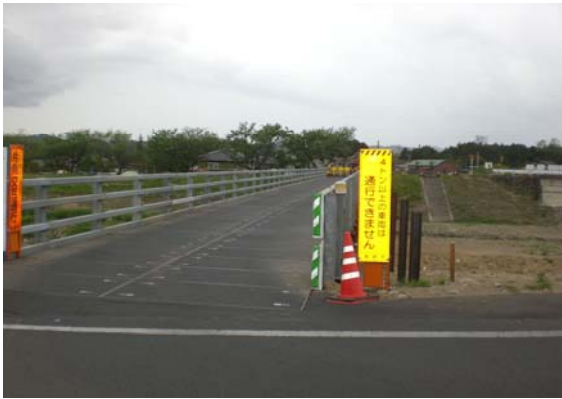
●仮設橋 (左岸側より)
