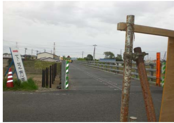
●仮設橋 (右岸側より)
