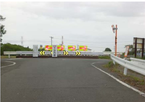
●右岸側 (天神橋架設予定箇所) (正面 西側)
