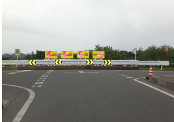
●左岸側 (天神橋架設予定箇所) (正面 東側)
