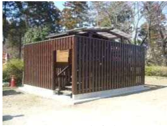
二の丸トイレ（工事後）
