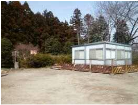
二の丸トイレ（工事前）
