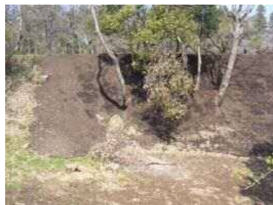
二の丸斜面（工事後）
