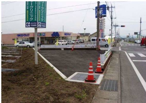
24年度 一部交差点改良施工済箇所 (生原信号付近)
