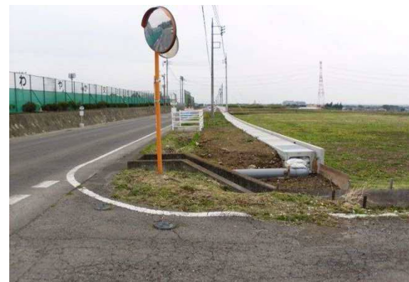
24年度 一部道路改良施工済箇所 (さわやか交流館南側)
