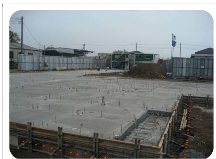
H26. 3月末工事状況
