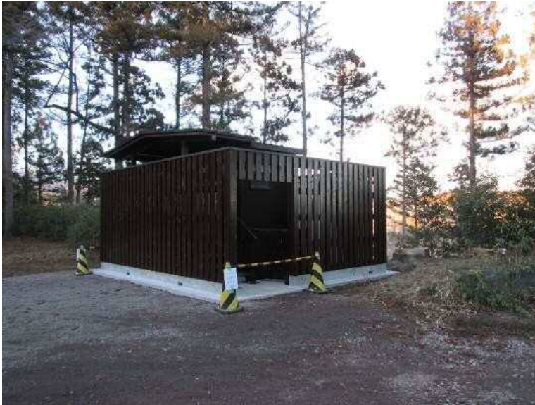
御前曲輪新設トイレ設置状況（25年度）
