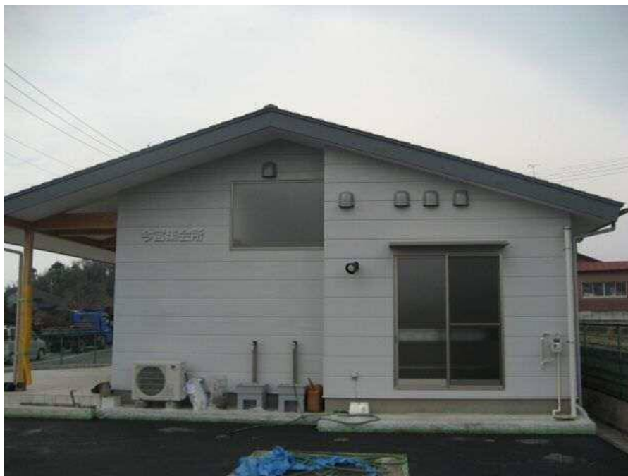
【外観】 東側から
