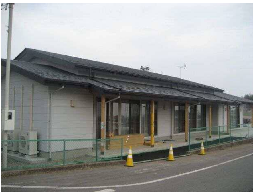
【外観】 南西から
