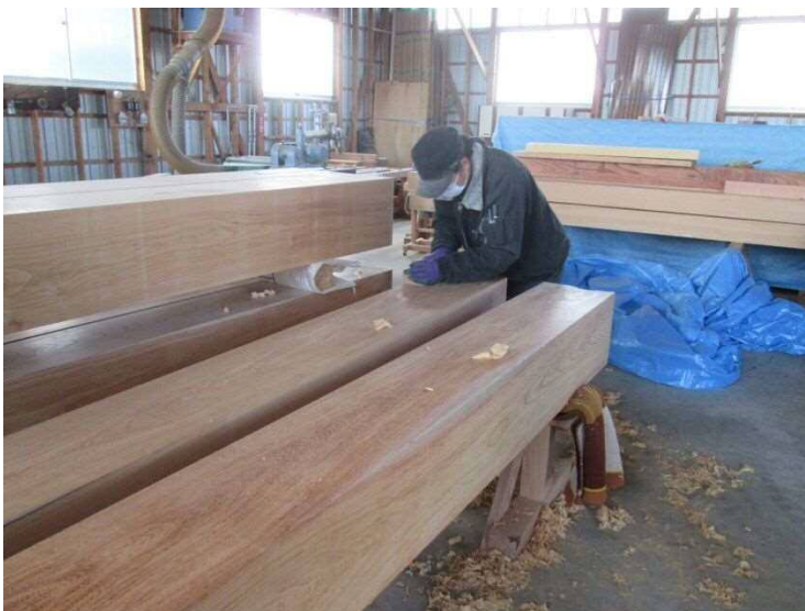
城門整備工事 1 年次 木材加工状況（26年度）
