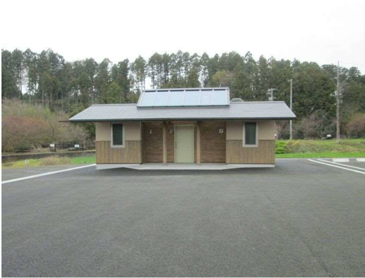
駐車場トイレ完成後（26年度）
