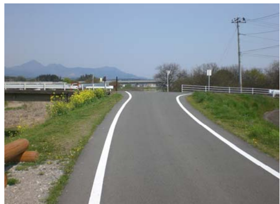
左岸側堤防上
