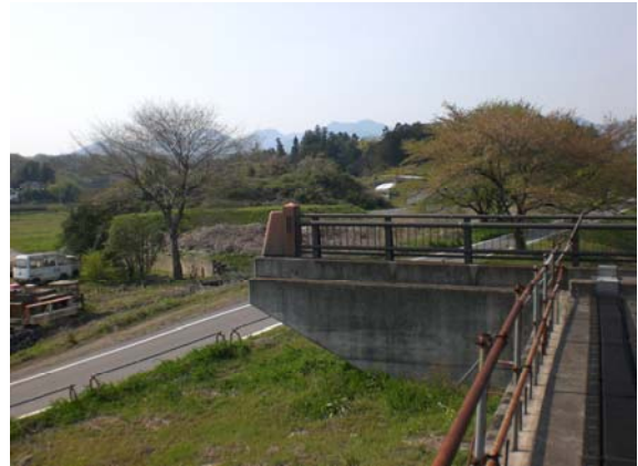
22年度施工予定箇所 (箕郷大橋西端から)
