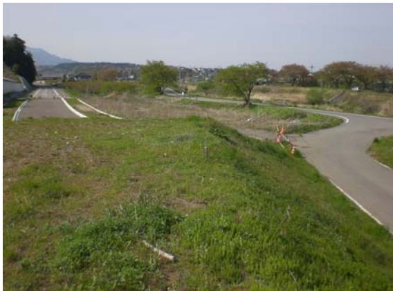
22年度施工予定箇所 (北に向かって)
