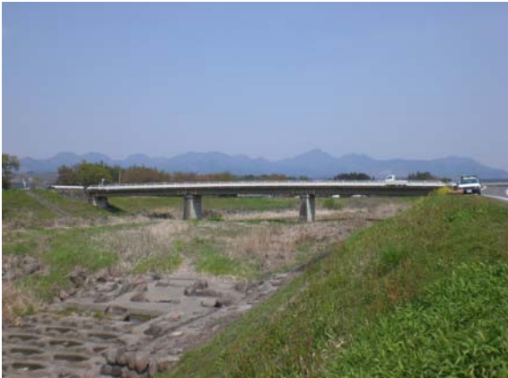
天神橋全景 (下流側から)
