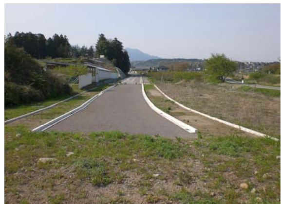
施工済み箇所
