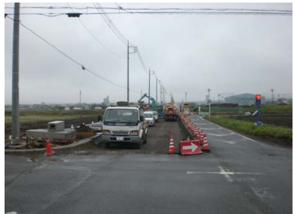
21年度施工箇所 (ハルナ育雛場西側)
