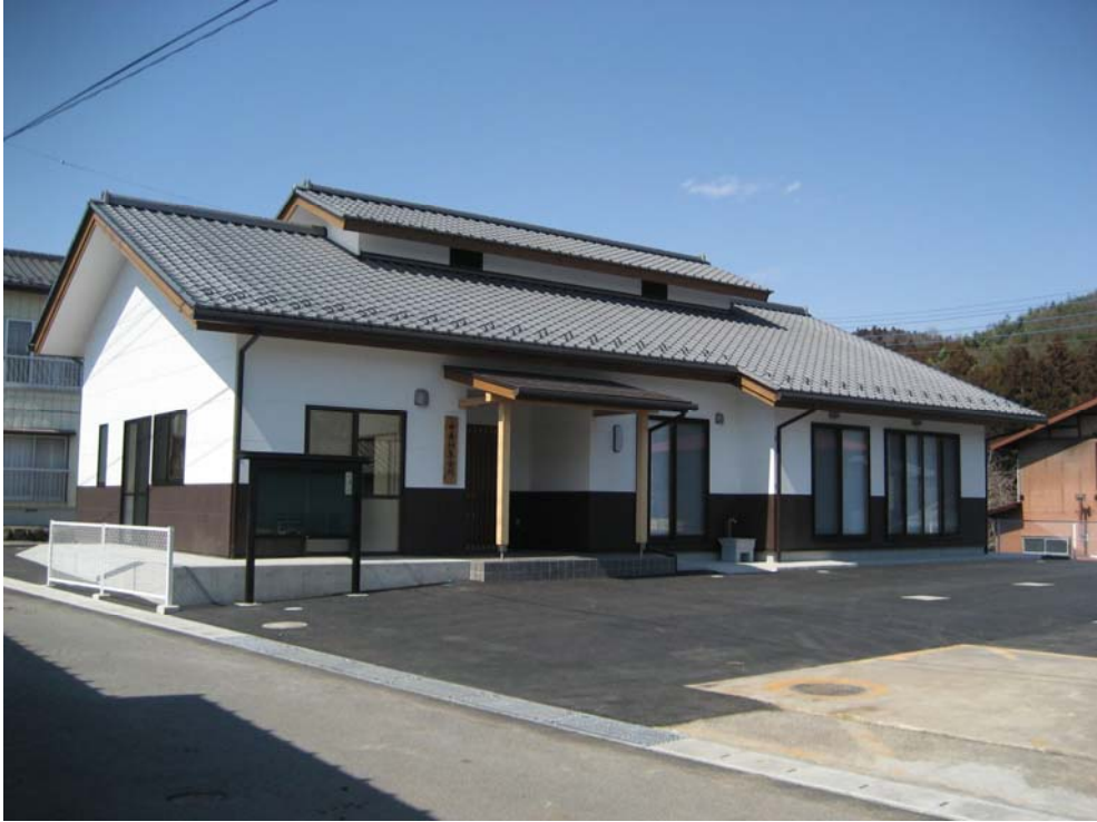
【建物南西側より】
