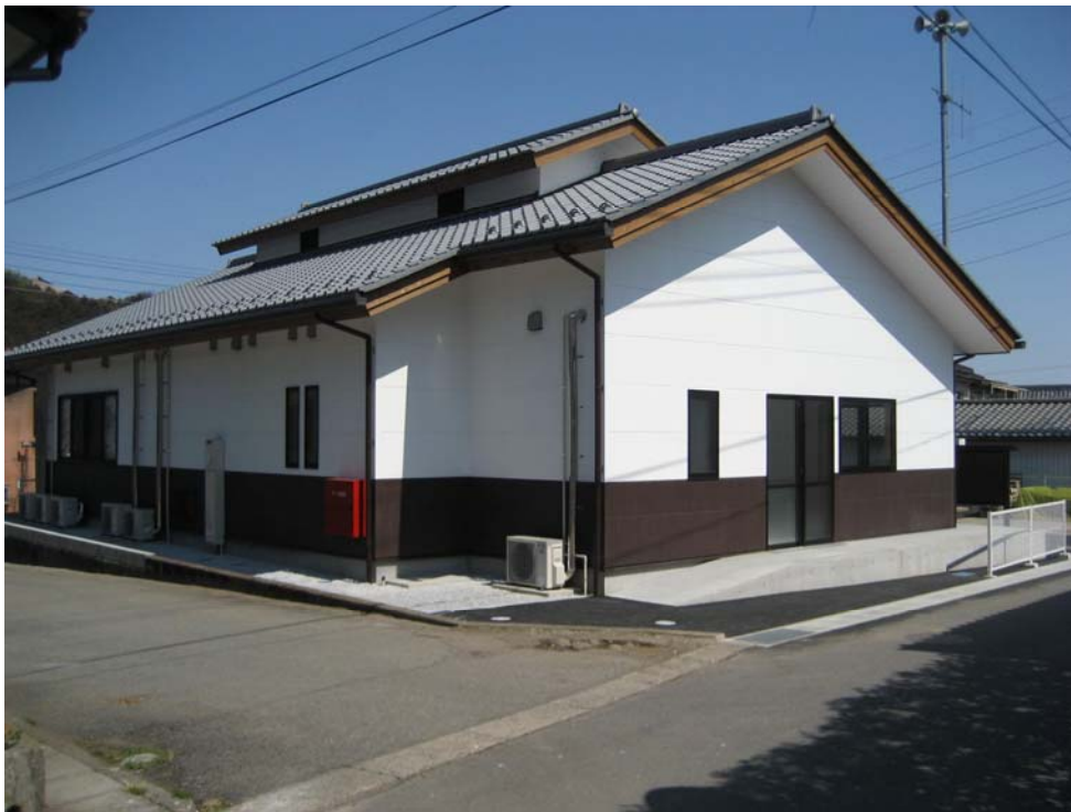
【建物北西より】
