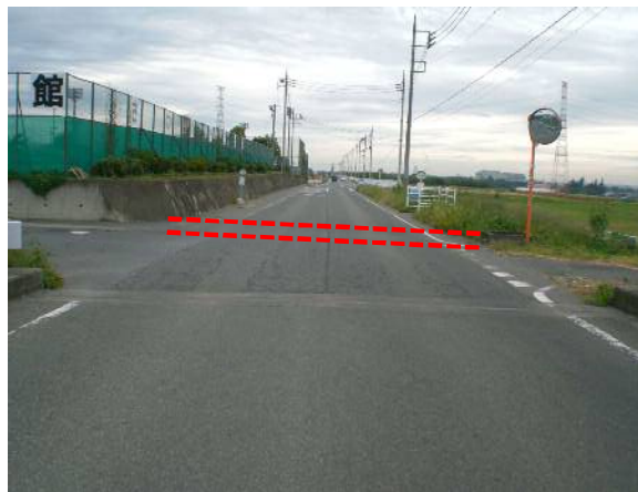
今年度 用水路横断暗渠施工予定箇所
