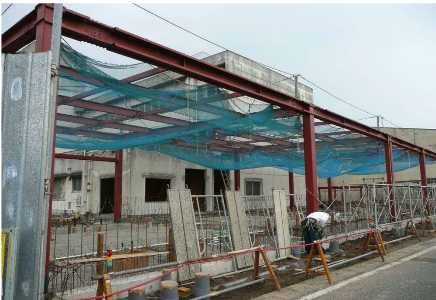
本体工事の状況②
