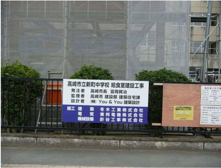
新町中学校給食室施工表示
