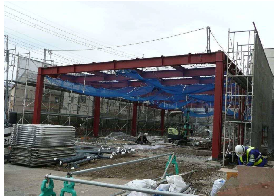
本体工事の状況
