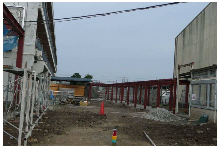
体育館への渡り廊下新設
