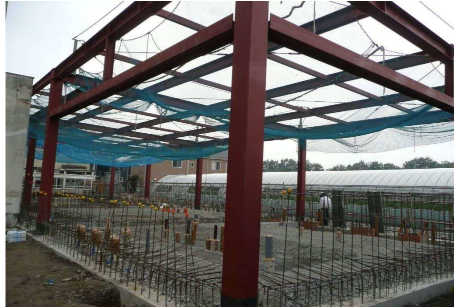
本体工事の状況①
