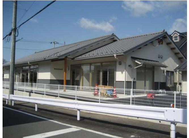
【第4区地区集会所南東より】
