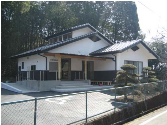
【上善地地区集会所北西より】
