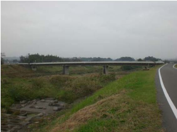
天神橋全景 (下流側から)
