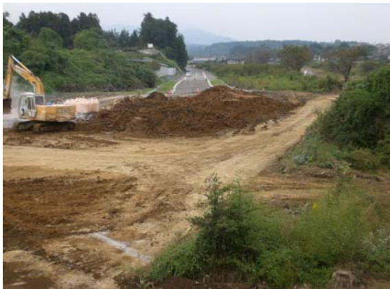
22年度施工予定箇所 (北に向かって)
