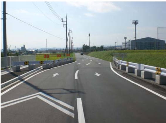
21年度施工箇所 (西に向かって)
