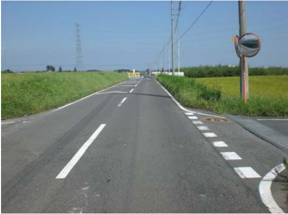
22年度施工予定箇所 (総合運動公園の南東)
