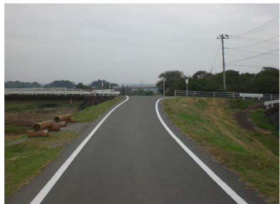
東側堤防上道路 (迂回路)
