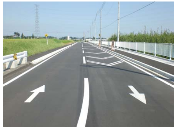
21年度施工箇所 (東に向かって)
