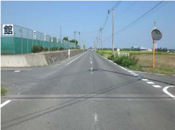
22年度施工予定箇所 (さわやか交流館の南)
