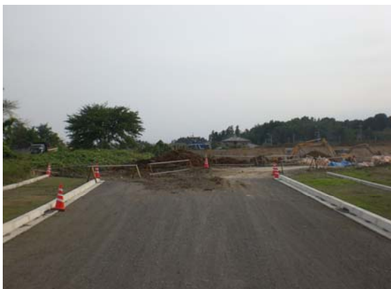
22年度施工予定箇所 (南に向かって)
