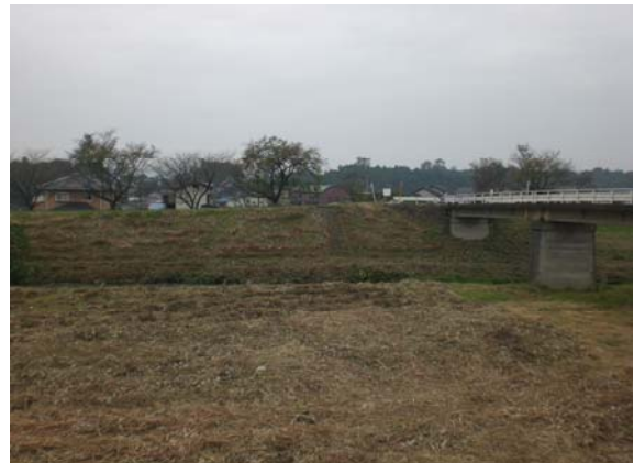
仮設橋梁設置予定箇所 (下流側)
