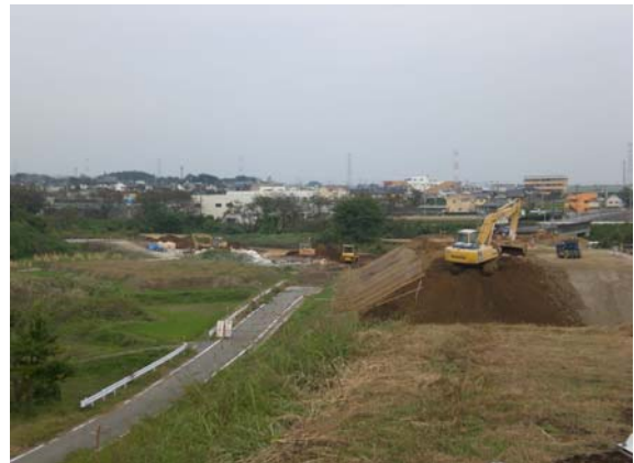
22年度施工予定箇所 (箕郷板鼻バイパスから)
