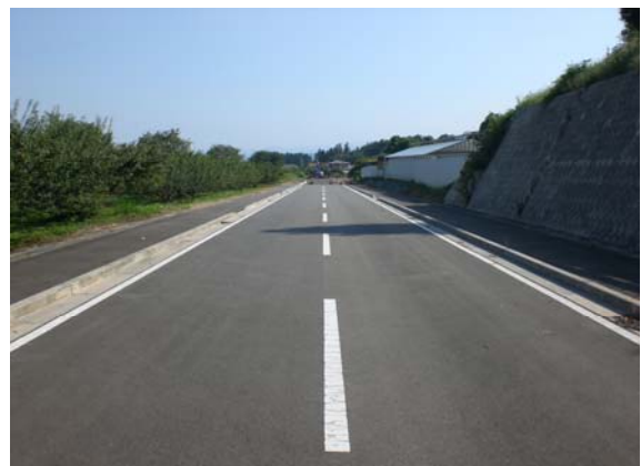
施工済み箇所 (富岡有機資源利用組合の東)
