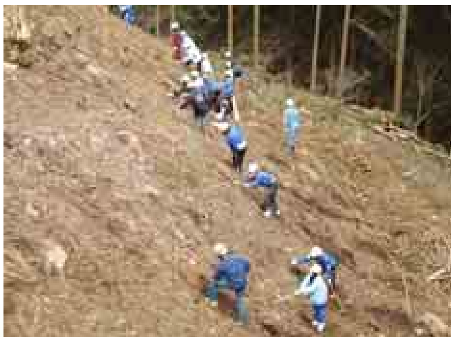
吉井町広葉樹林化事業の様子
