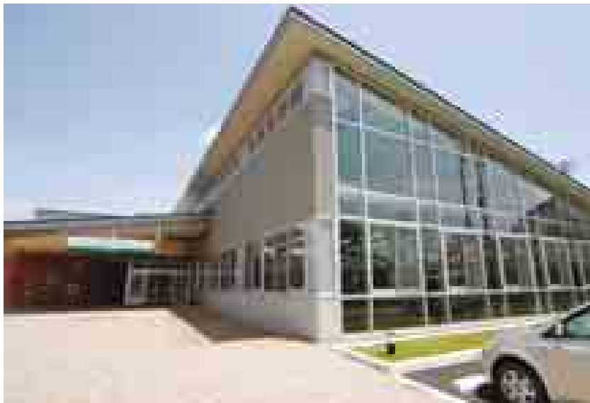
建替された新町図書館
