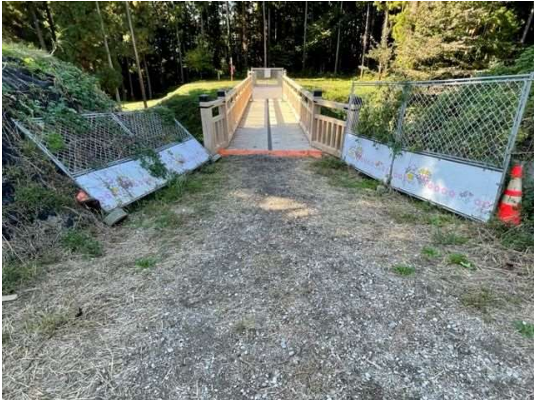
本丸西虎口整備工事箇所（着手前）
