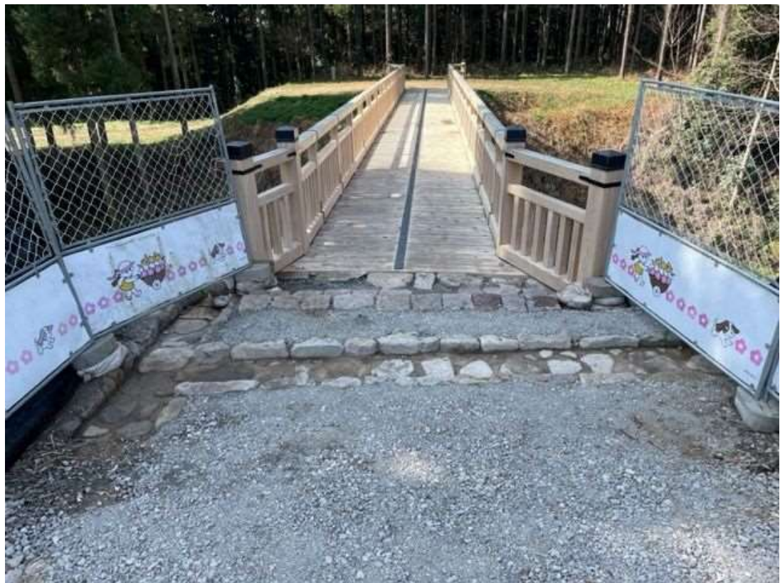
本丸西虎口整備工事箇所（完成後）
