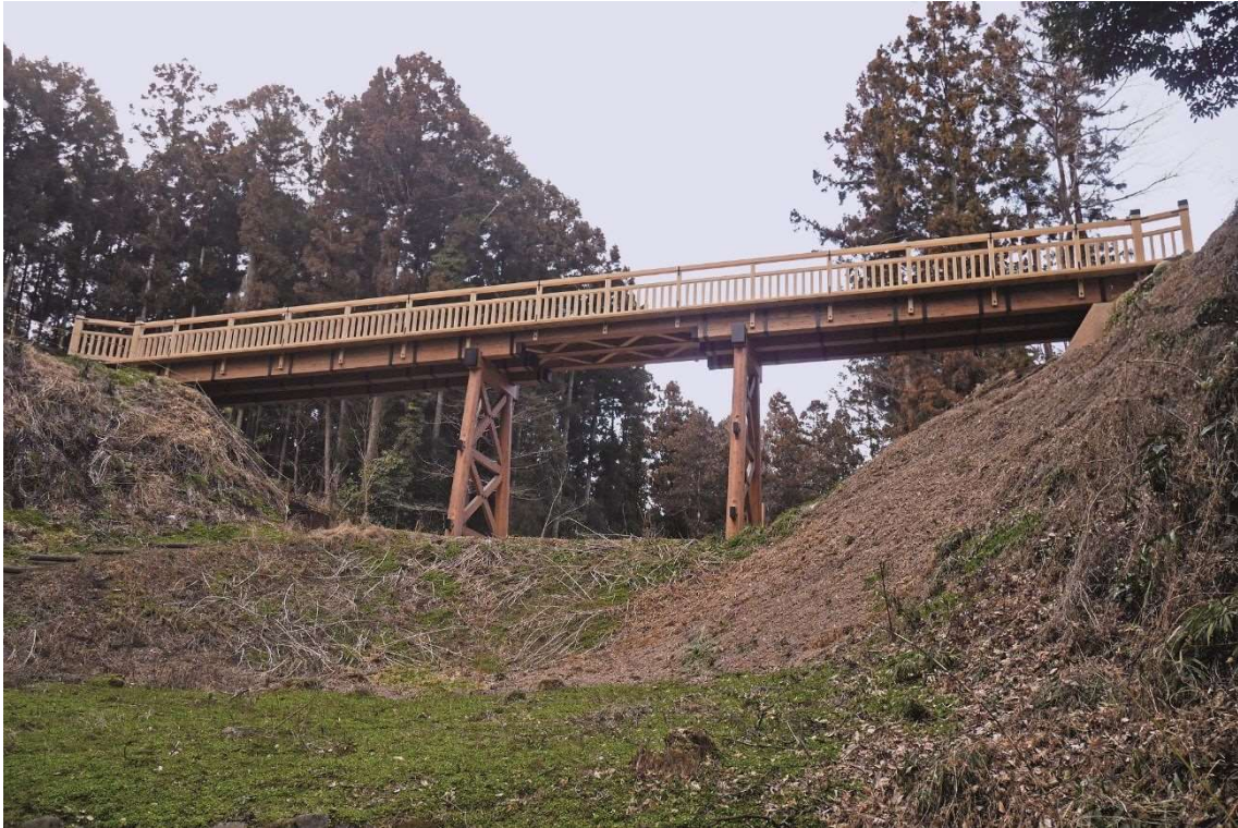
本丸・蔵屋敷間木橋完成状況
