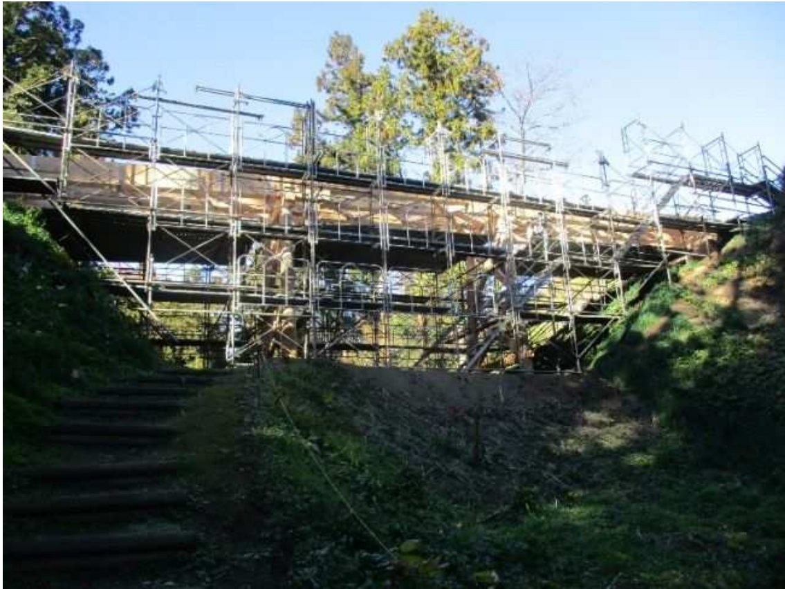
枠組み足場 仮設状況
