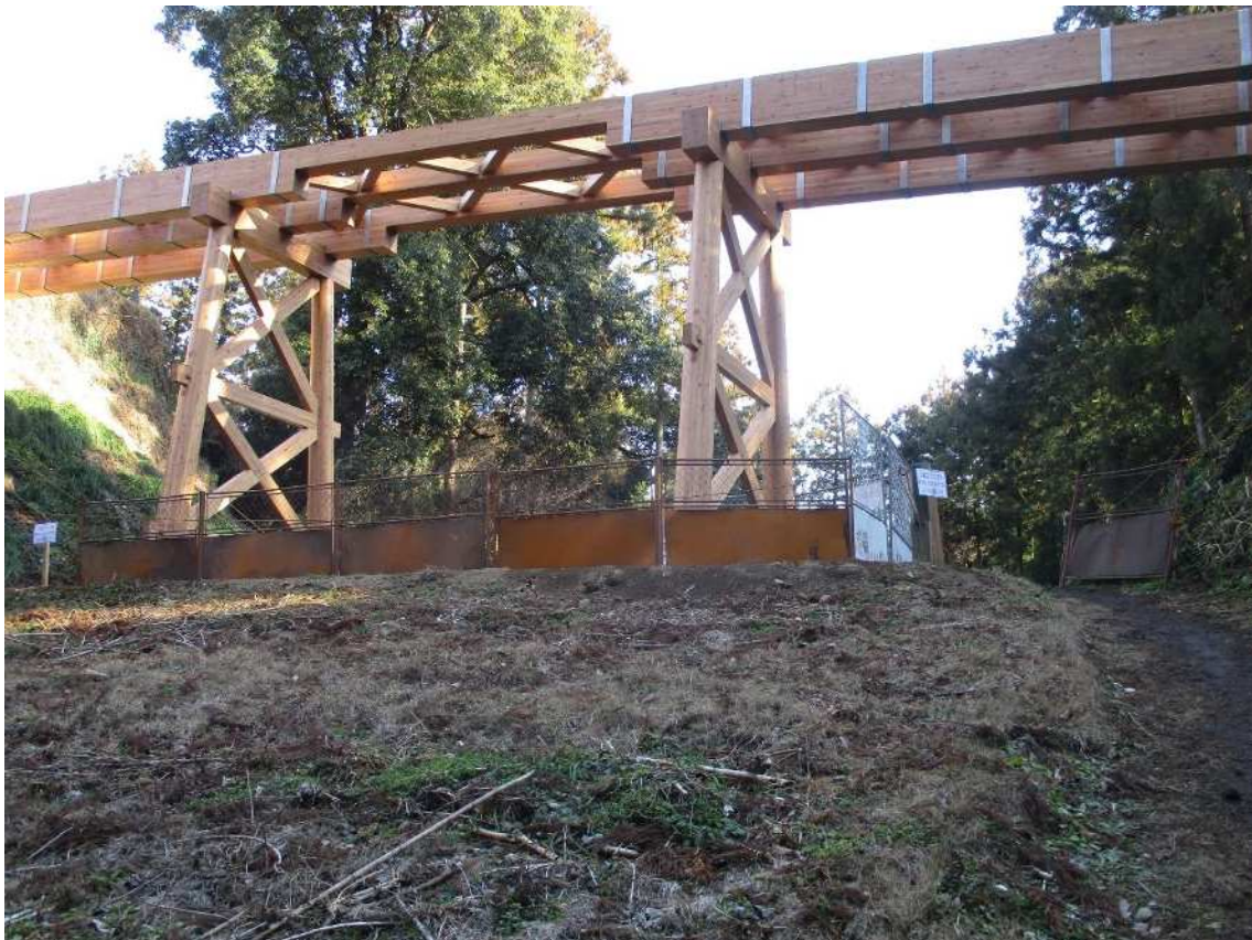
橋脚・橋桁完成状況
