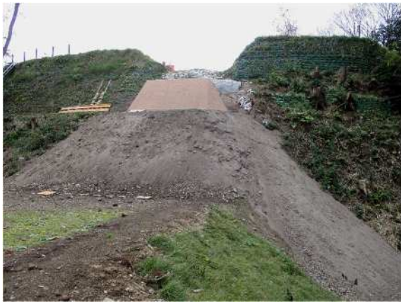
橋台基礎完成状況
