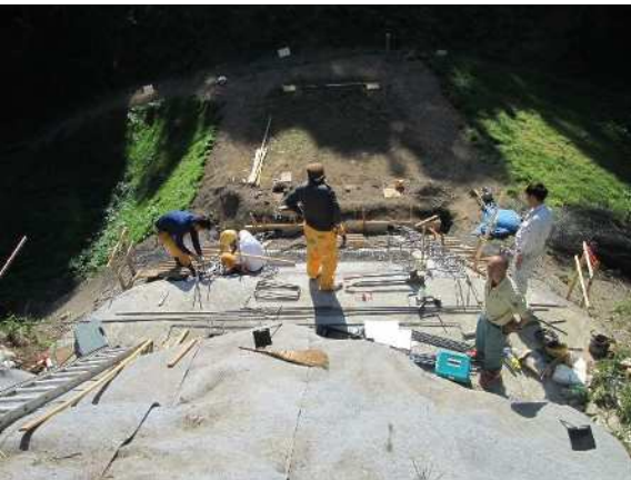
橋台基礎工事状況
