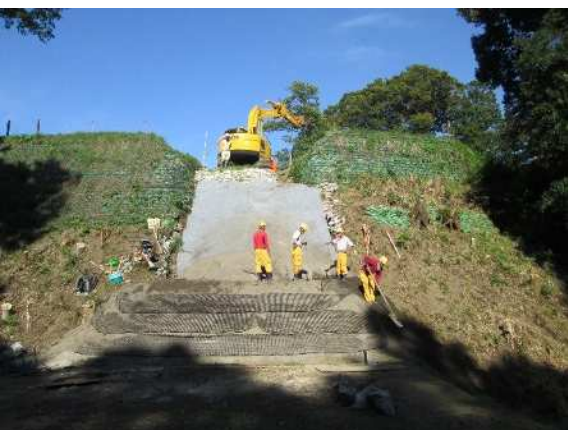
橋台基礎工事状況（盛土補強材敷設）
