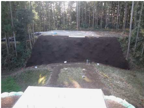
本丸木橋法面盛土完成状況
