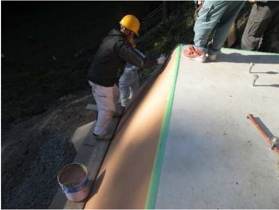
橋台基礎工事状況（外壁）
