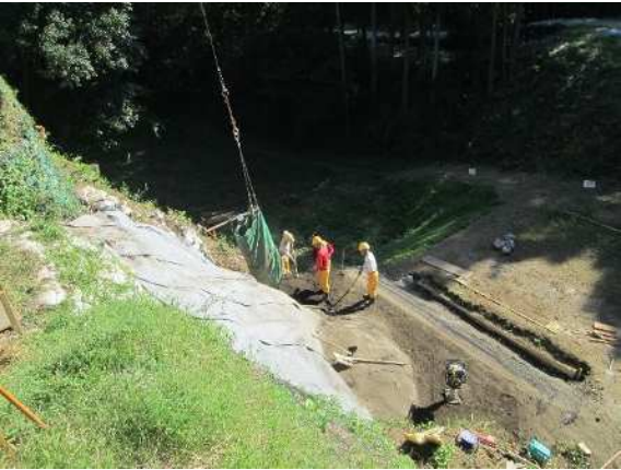
本丸木橋法面盛土工事状況
