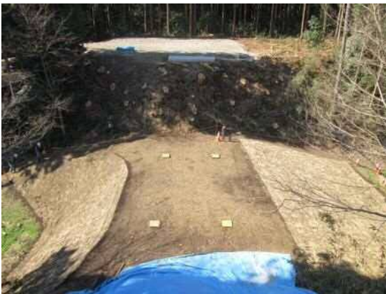
本丸木橋基礎工事完成状況①
