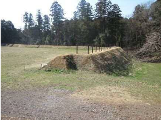
本丸土墨完成状況①
