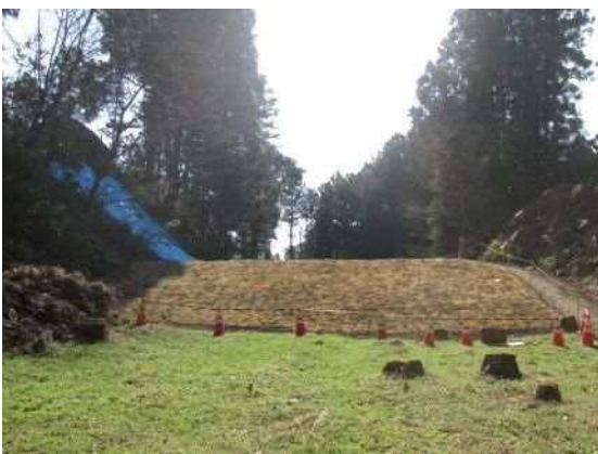
本丸木橋基礎工事完成状況②
