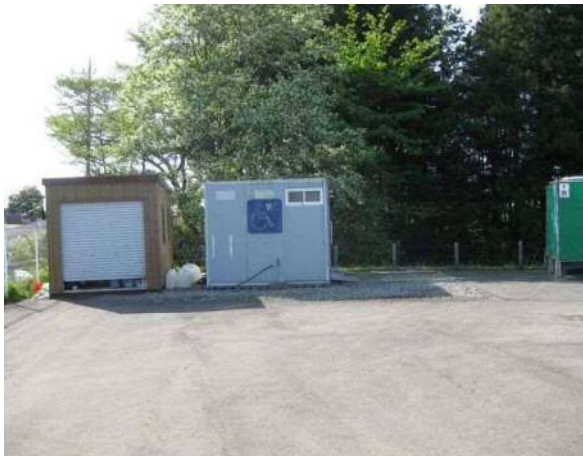
北から撮影した写真1
