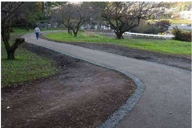
園路整備完成状況
