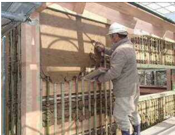
2階土壁荒塗状況
