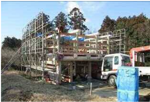
2階建て方状況
