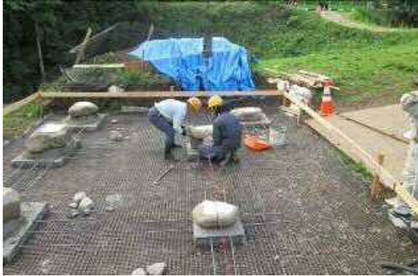
礎石据付状況
