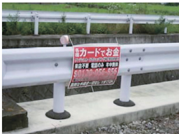
ガードレールに鉄板を プラスチックで固定
