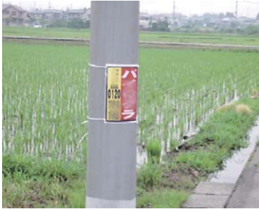
電柱にプラスチック板を ビニル紐で固定
