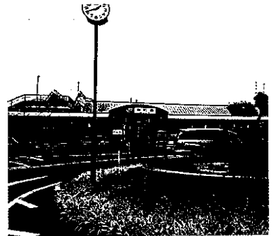
エレベーターが設置される新町駅
