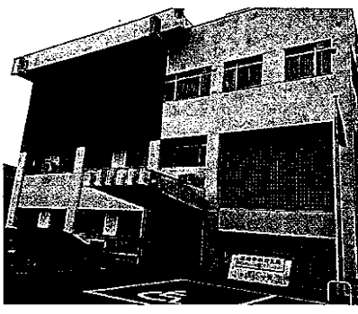
防災拠点として移転が望まれる新町支所
