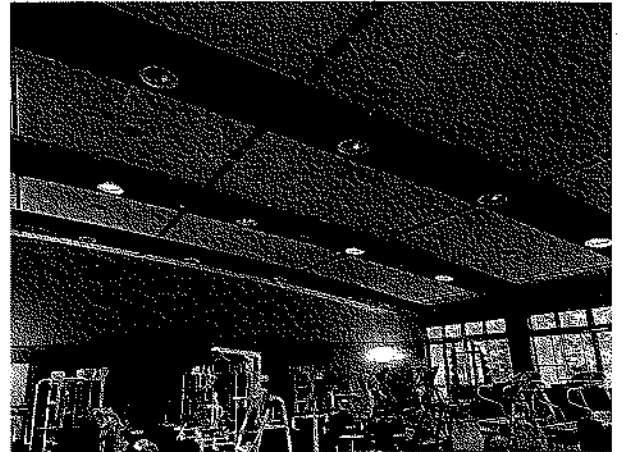
とある公共施設の照明です。ご覧の通り照明器具の半分以上が不灯のままです。
