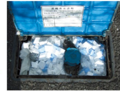
▲ 発泡スチロールを入れたビニール袋をメーターボックス内に詰めた状態
