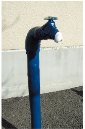
▲ 保温材をビニールテープで巻いた状態
