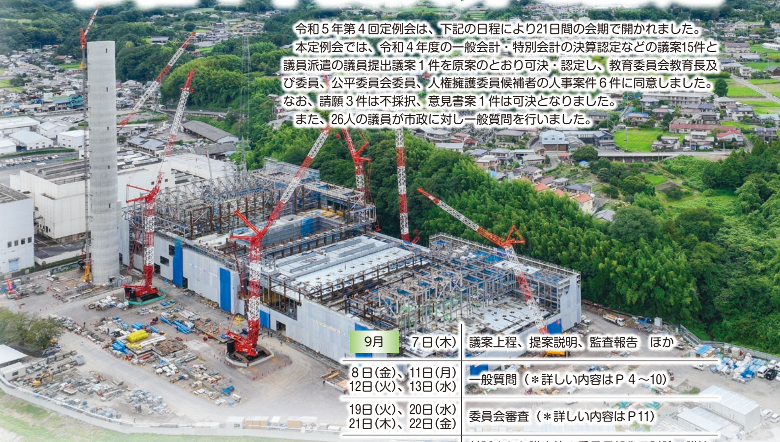
建て替えが進む高浜クリーンセンター
