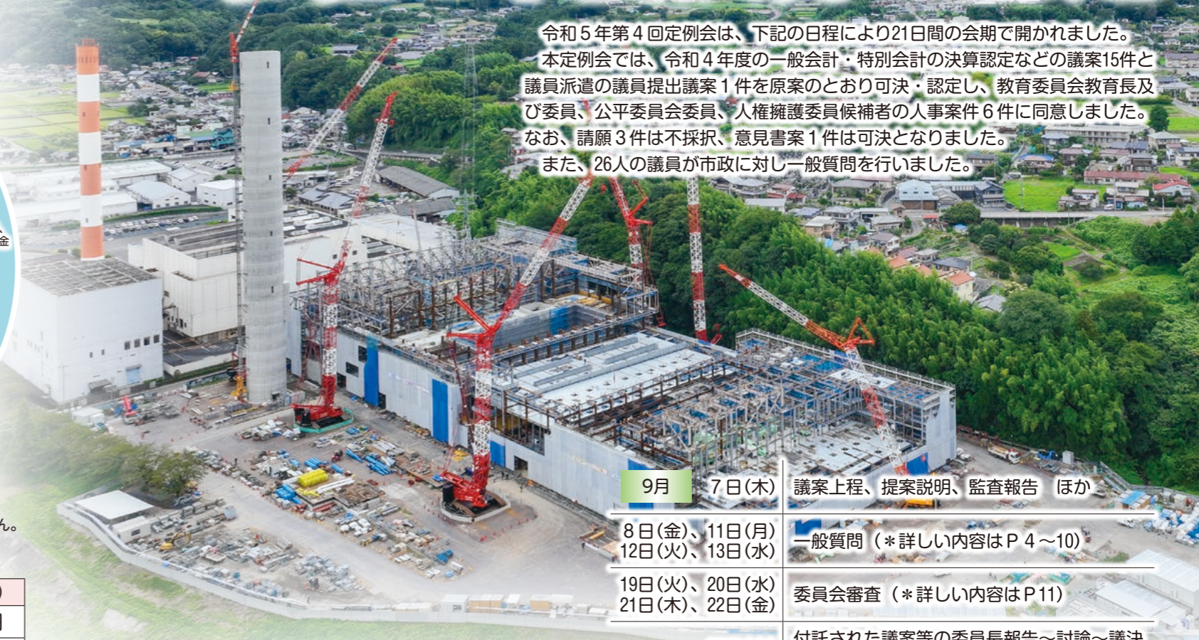
建て替えが進む高浜クリーンセンター
