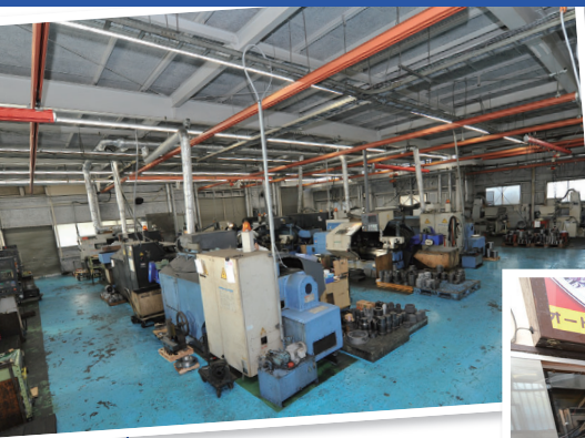
暑さ対策で工場に遮断熱塗装を施した。保温効果もあり、室内は冬も快適に
