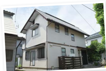
外壁の塗り直しや雨どいの補修などにも
