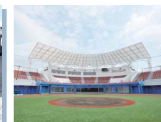
ウツギスタジアム UTSUGI STADIUM開場など整備が進む浜川運動公園(土木費)
