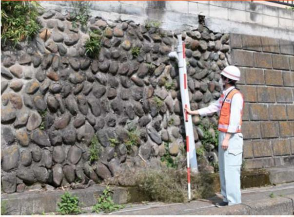
傾斜地では、のり面にゆがみや亀裂が入ったり、表面が剥がれたブロックが抜け落ちたりする箇所などを確認。今後補修などを実施予定
