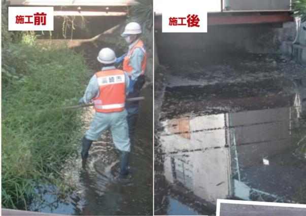
円滑な水の流れを確保するため、水路内の植物や土砂を撤去。破損などのあるマンホールの蓋を交換
