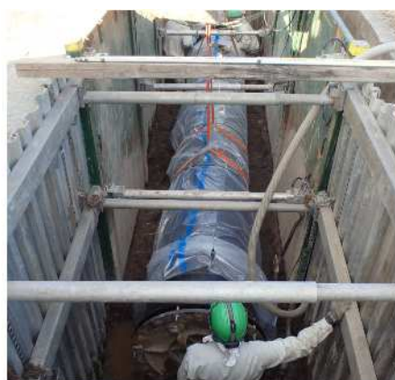
耐震管 800mm 布設状況
