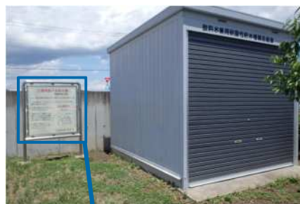
図 2-16 緊急用給水設備保管庫
