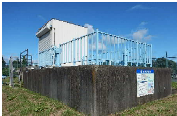
図 2-25 若田発電所（小水力）
