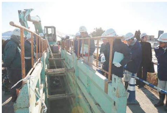
技術的な観点で実施される下水道の工事監査
