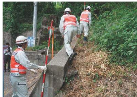
毎年実施している市職員による危険箇所総点検
