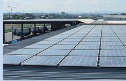
太陽光パネル設置状況
