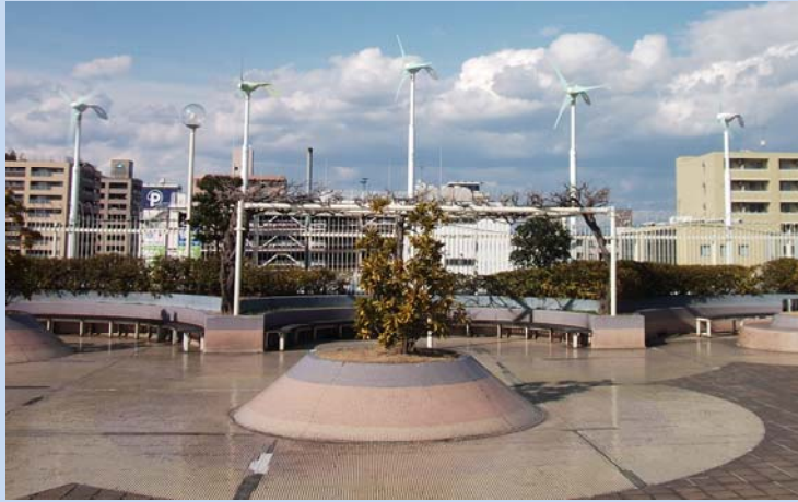
施設屋上の風車(5基)設置状況
