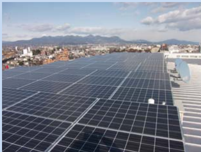
太陽光パネル設置状況
