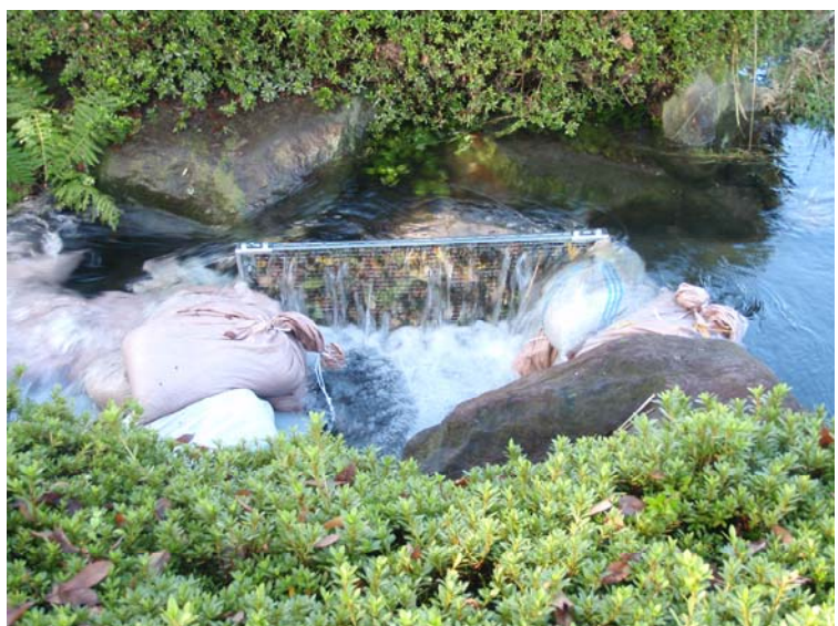
細目スクリーンの塵芥により 導水管への供給が不足 (水位差の発生)
