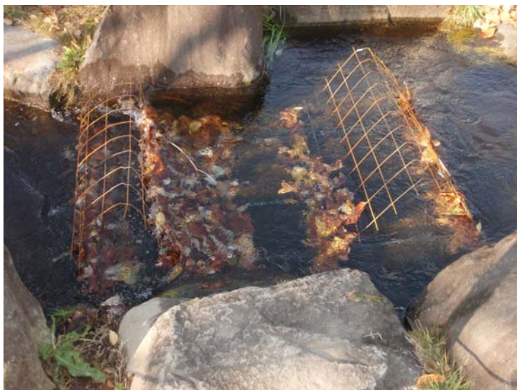
取水口上流荒目スクリーン (小枝や大きめの枯葉)
