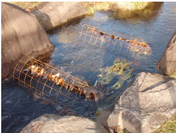
取水口上流荒目スクリーン
