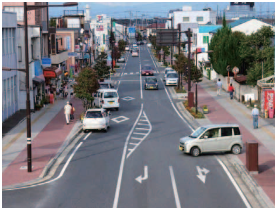
基盤整備が進む(都)駅前通り線（(県)新町停車場線）
