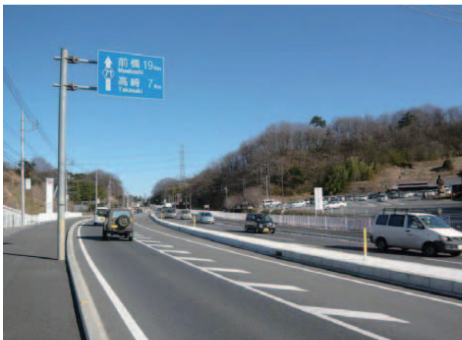
高崎地域と吉井地域を結ぶ(都)矢田岩崎線
