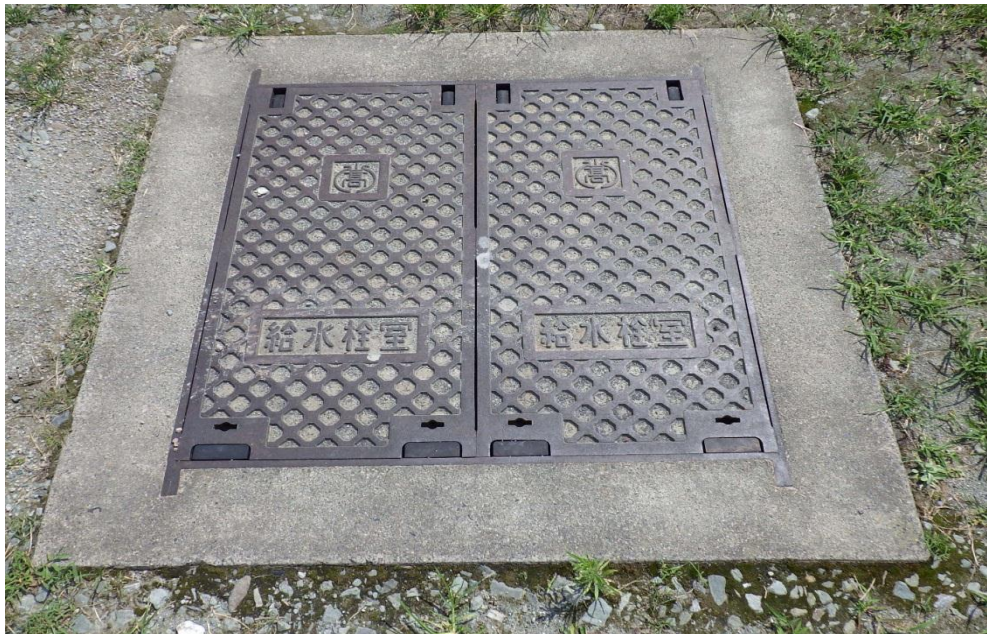
耐震性貯水槽
