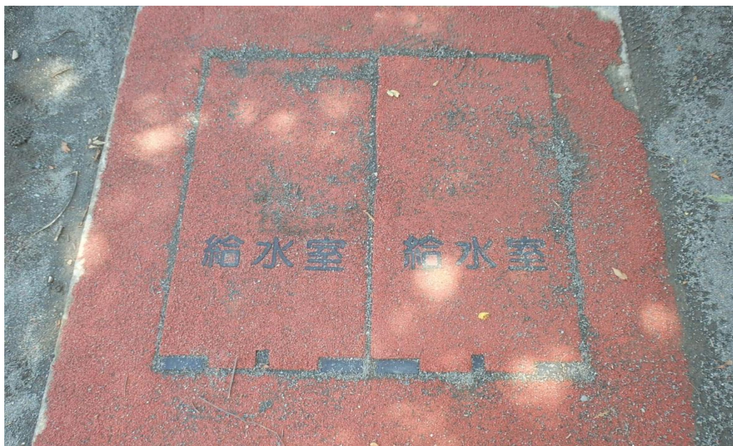
耐震性貯水槽
