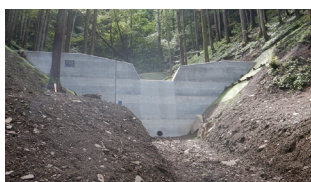
治山事業により施工された治山ダム
