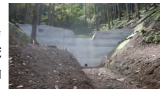
治山事業により施工された治山ダム
