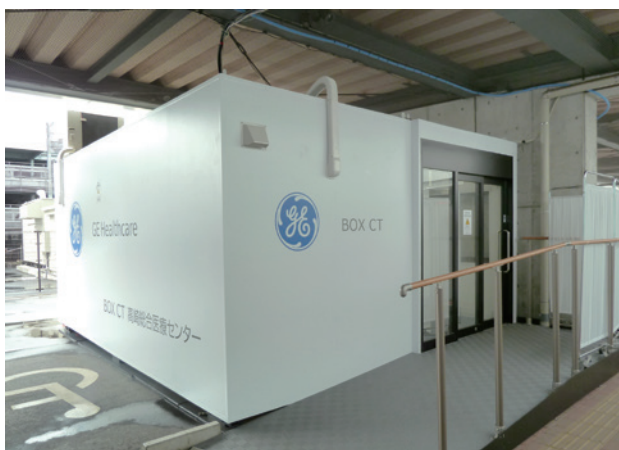
発熱者専用のコンテナ型簡易CT室
