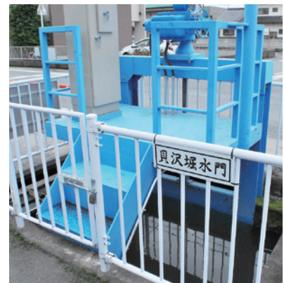
長寿命化工事により改築した水門
