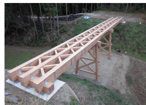
令和2年度に設置した橋脚と橋桁
