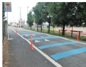
交通安全対策として設置したハンプ
