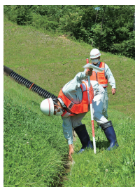
危険箇所総点検の様子
